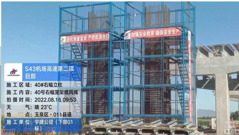
S43 呼和浩特机场高速公路第二项目部桥梁工程
